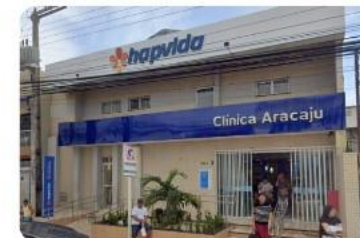
Clínica Aracaju Rua Campo do Brito, 1180 - Bairro São José Aracaju - SE
